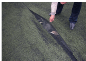
Los terrenos con costuras descosidas no son seguros y aumentan el riesgo de lesiones
